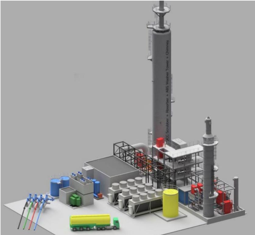
Bild 1: Mittelgroße Anlage zur CO<sub>2</sub>-Abscheidung für 200.000 t CO<sub>2</sub>/a: Flächenbedarf ca. 30 m x 50 m; Dampfbedarf ca. 1 MW<sub>th</sub>/t CO<sub>2</sub>; Strombedarf ca. 0.2 MW<sub>el</sub>/t CO<sub>2</sub> mit Verflüssigung bzw. ca. 0.05 MW<sub>el</sub>/t CO<sub>2</sub> ohne Verflüssigung/Verdichtung; Kühlbedarf ca. 1.2 MW<sub>th</sub>/t CO<sub>2</sub> (Bild: Bilfinger Engineering & Maintenance)
