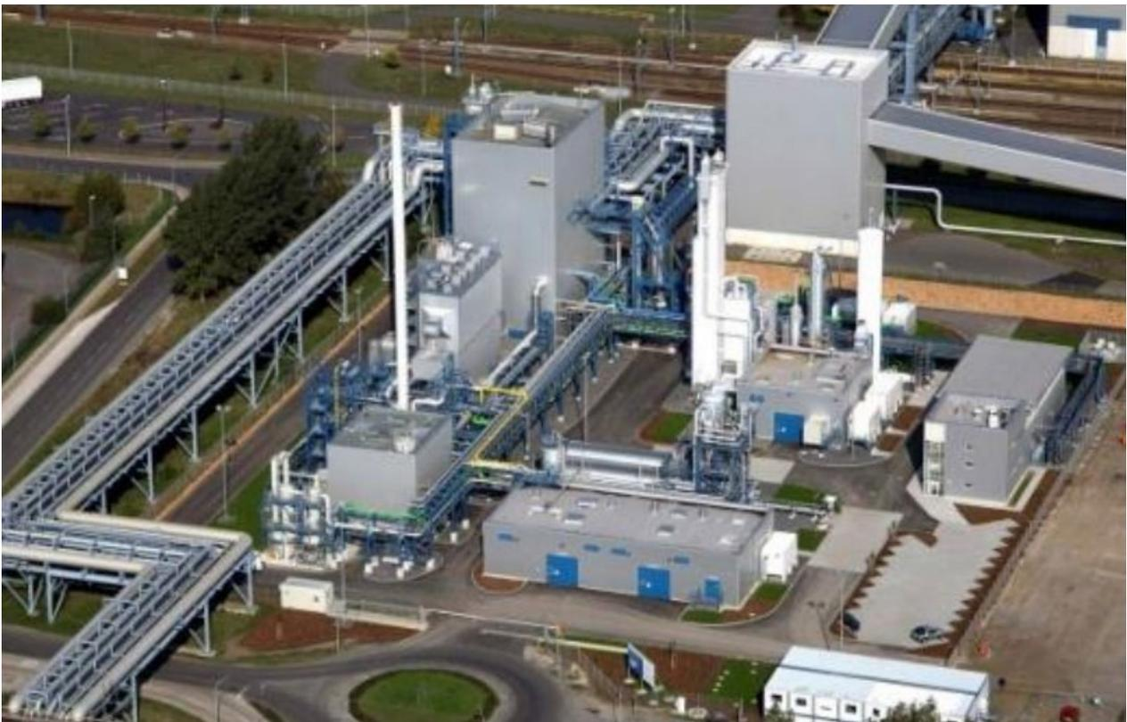
Bild 3: Demonstrationsanlage Braunkohlekraftwerk Schwarze Pumpe bei Spremberg: thermische Leistung 30 MW<sub>th</sub>; Inbetriebnahme 2008; CO<sub>2</sub>-Abscheidung mit dem Oxy-Fuel-Verfahren. Nach erfolgreichem Betrieb wurde diese Technik in Deutschland nicht weiterverfolgt. (Bild. Vattenfall Deutschland)
