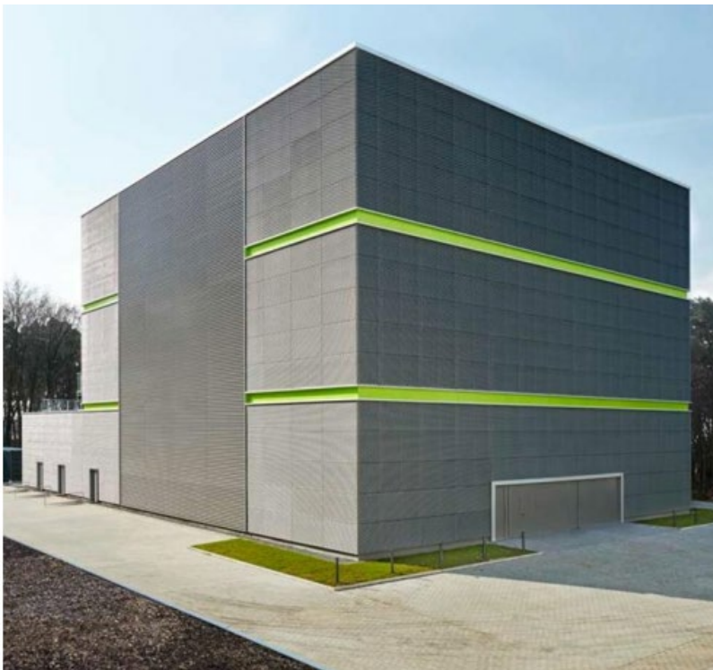
Neubau des energieeffizienten Großrechenzentrums „GSI Green IT Cube“ (Bild: picture-alliance/dpa/GSI Helmholtzzentrum)
